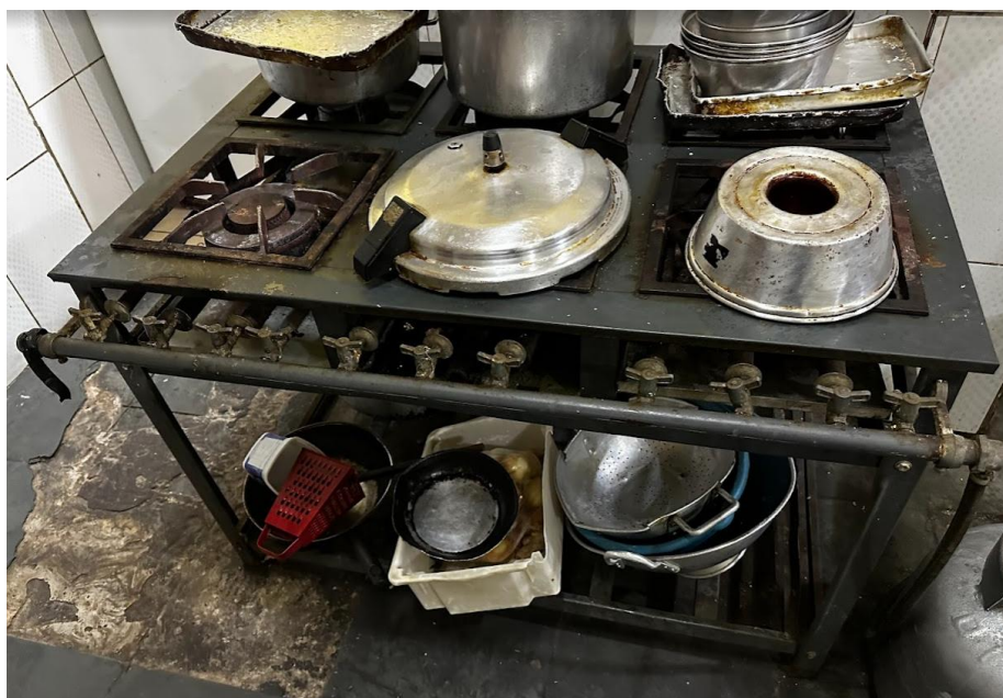
Item vii) fogão industrial, 6 bocas, a gás.
