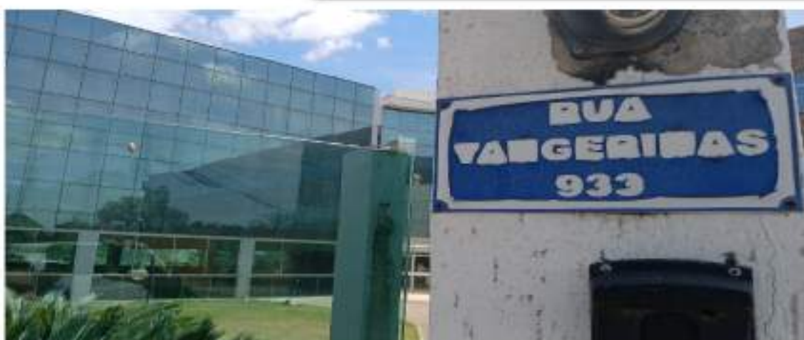
Figura 02 - Placa de identificação do endereço do imóvel.
